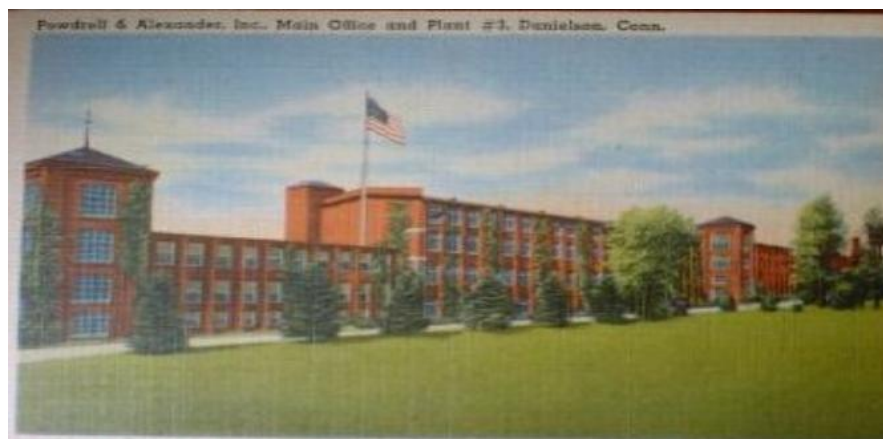
Selon le site Web : Connecticut Factories and Jobs Lost, la filature Powdrell & Alexander de Danielson employait entre 1000 à 1500 ouvriers. Est-ce celle de Pierre Z.*** ?
